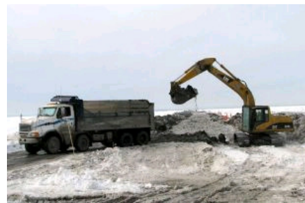
Reprofilage du chenal Landroche à Baie-du-Febvre (Photo, Carole Montembeault)
